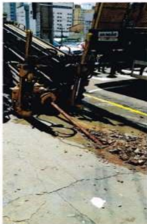
MAQUINA DE PERFURAÇÃO DE SOLO – CAMPO GRANDE / MS.
