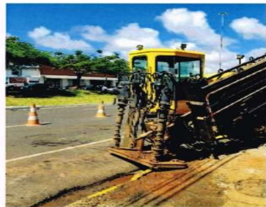
MAQUINA DE PERFURAÇÃO DE SOLO – CAMPO GRANDE / MS.
