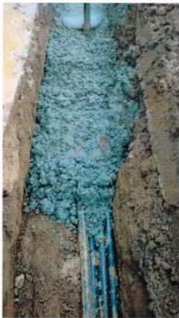
ENVELOPAMENTO DE DUTO – CAMPO GRANDE / MS.
