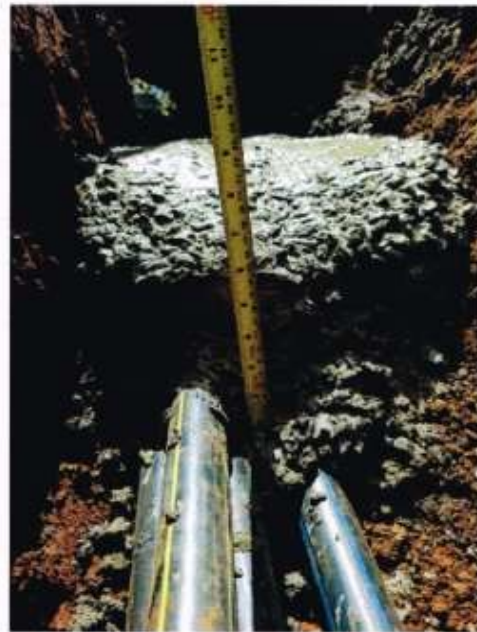
ENVELOPAMENTO DE DUTO – CAMPO GRANDE / MS.
