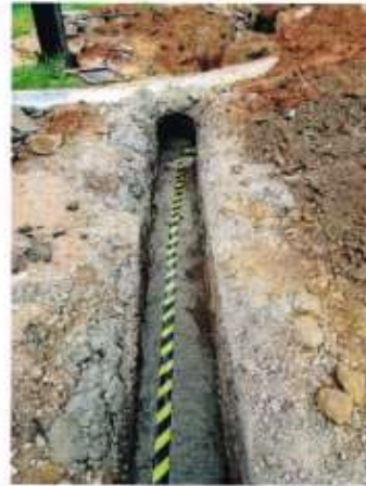
ENVELOPAMENTO DE DUTO – CAMPO GRANDE / MS.
