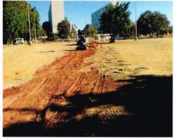
FECHAMENTO DE VALA – Brasília / DF
