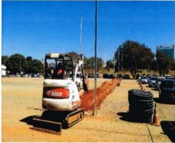
ESCAVAÇÃO MD – Brasília / DF
