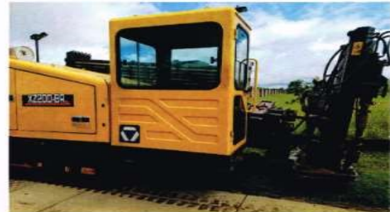
MAQUINA DE PERFURAÇÃO DE SOLO – CAMPO GRANDE / MS.
