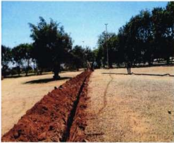
LANÇAMENTO DE PEAD – Brasília / DF
