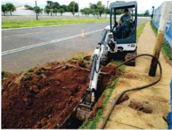
LINHA DE DUTO SUBTERRÂNEA – CAMPO GRANDE / MS.
