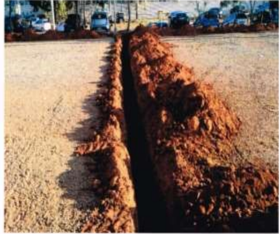
ESCAVAÇÃO MD – Brasília / DF
