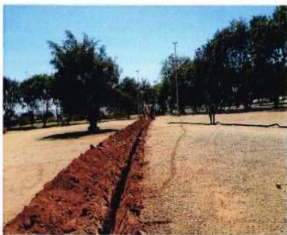
LANÇAMENTO DE PEAD – Brasília / DF
