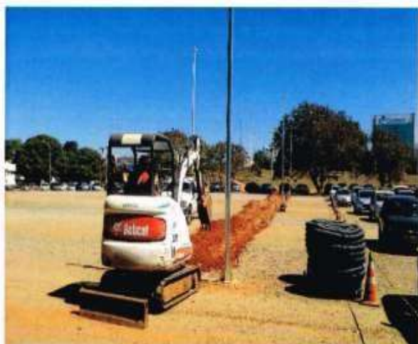
ESCAVAÇÃO MD – Brasília / DF
