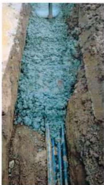
ENVELOPAMENTO DE DUTO – CAMPO GRANDE / MS.
