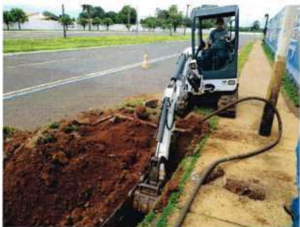
LINHA DE DUTO SUBTERRÂNEA – CAMPO GRANDE / MS.
