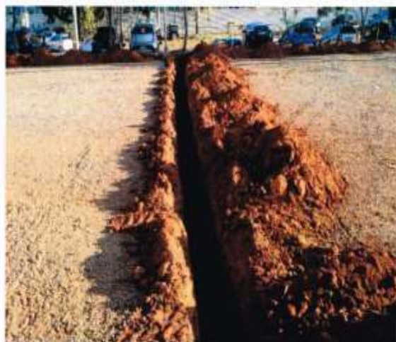
ESCAVAÇÃO MD – Brasília / DF
