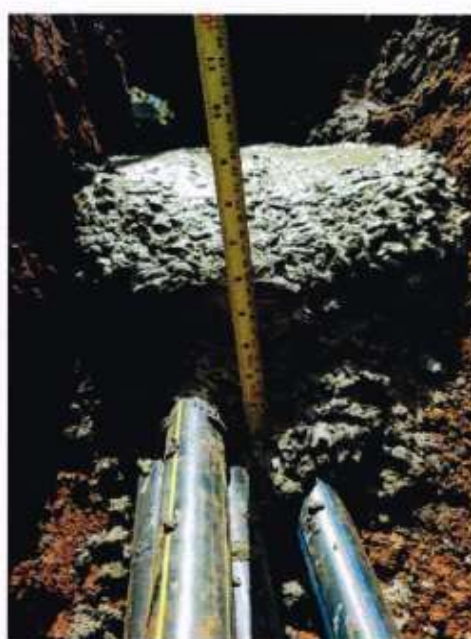
ENVELOPAMENTO DE DUTO – CAMPO GRANDE / MS.
