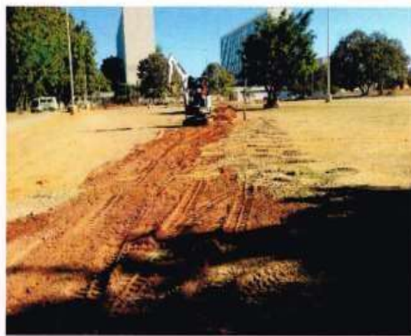
FECHAMENTO DE VALA – Brasília / DF
