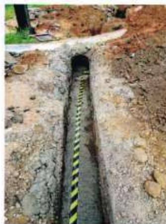
ENVELOPAMENTO DE DUTO – CAMPO GRANDE / MS.
